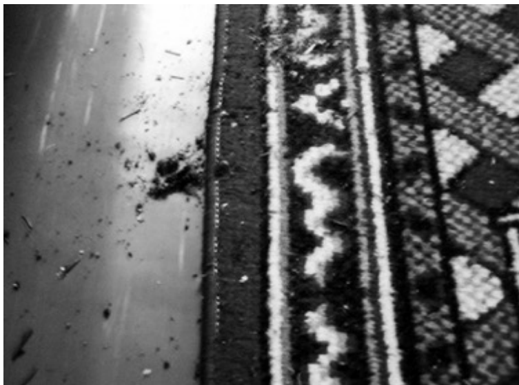
F.1.8. ábra Intenzív rovartevékenység és korhadás jeleit mutatja a födémgerendáról a padlóra hullott rágcsálék, Forrás: a szerző által készített digitális fotográfia, Sukoró, Fejér megye 2013.04. 28.
