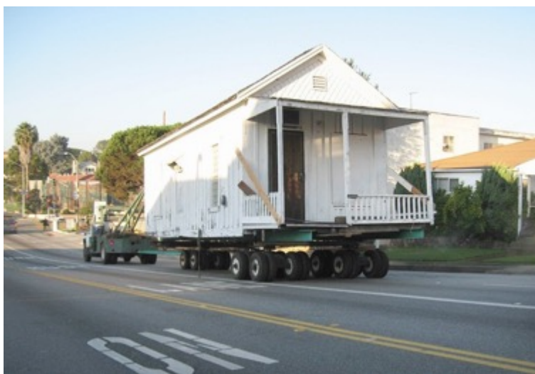
2.3.2. ábra A shotgun house szerkezeténél fogva akár készen, összeszerelve is szállítható Forrás: http://articles.latimes.com/2010/jan/23/local/la-me-shotgun-house23-2010jan23 , 2012.05.26.
