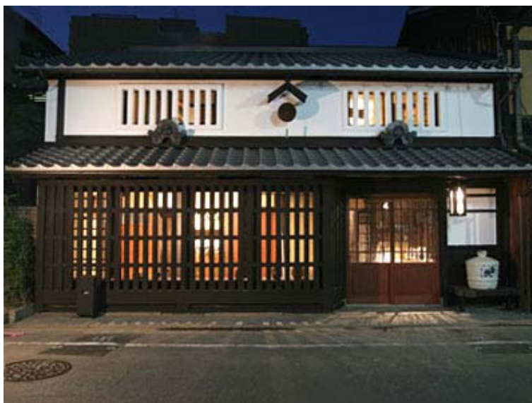
2.2.7. ábra Egy „kiomachiya” (kiotói városi lakóház) homlokzata
