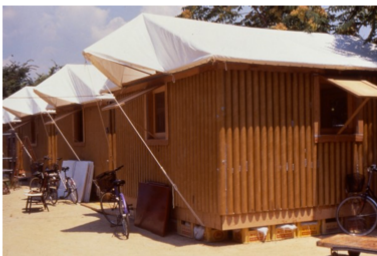
2.5.7. ábra Shigeru Ban (2005) Földrengés sújtotta területre tervezett átmeneti kartonházak, Kobe, Japán Forrás: https://luisgrislyf.files.wordpress.com/2013/12/p3.jpg , 2015.11.06.
