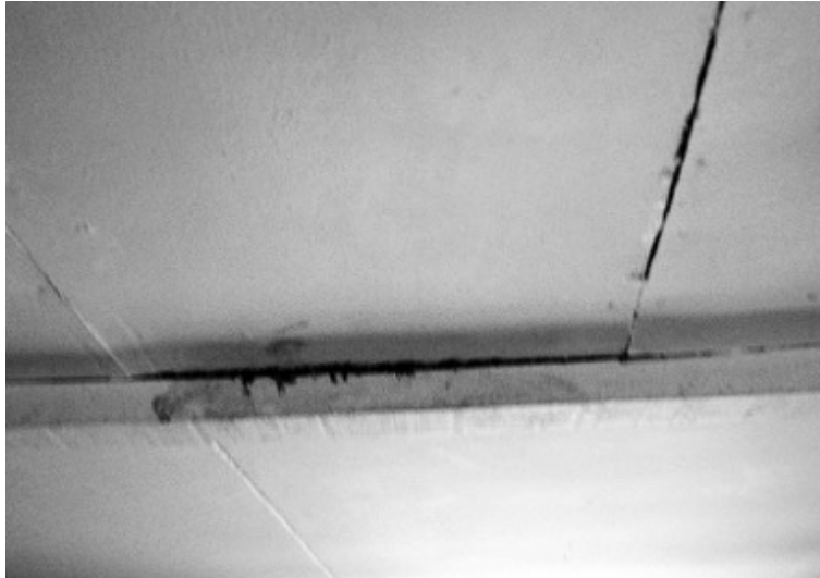
F.1.7. ábra Szerkezeti faanyagban keletkezett biotikus és abiotikus károk a vizsgált „Egervár” típusú hétvégi ház tetőfödém szerkezetén
