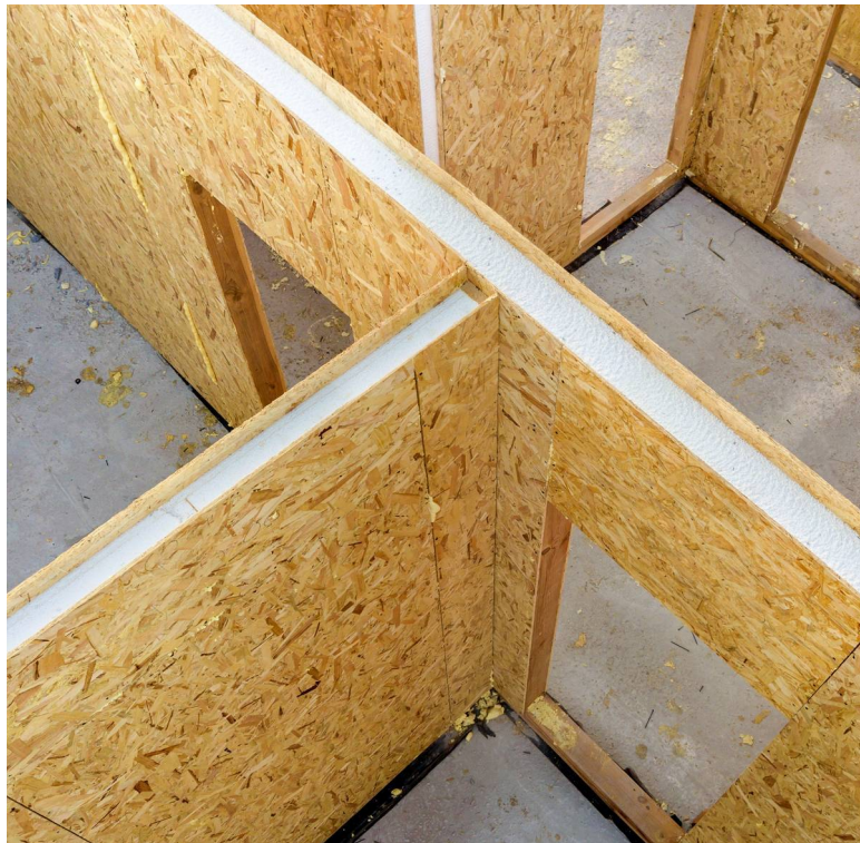
2.5.5. ábra SIP technológiával épült lakóépület
