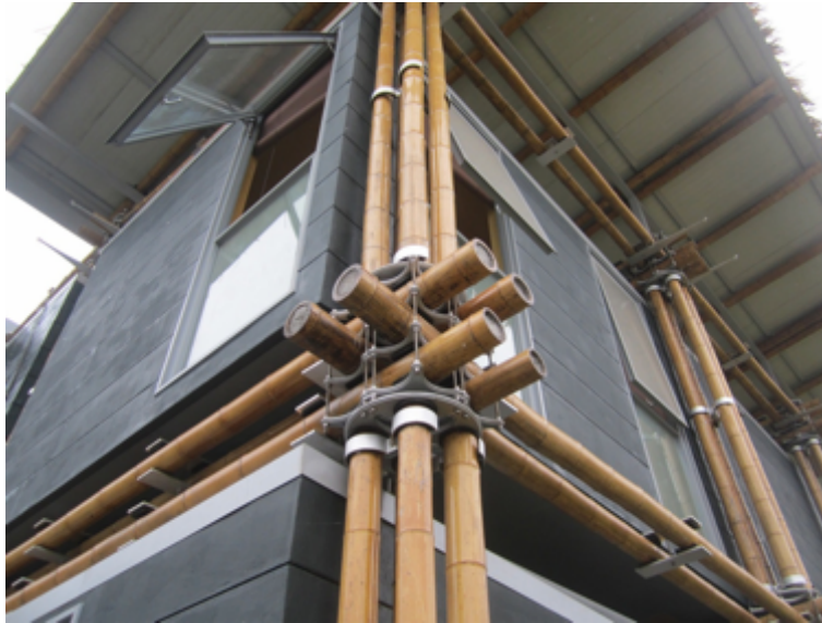
3.39. ábra: Bambuszrudakból épített ortogonális vázrendszer és az erre illesztett térelemek, Studio Cardenas Conscious Design (2016) Energiatakarékos bambuszház, Lishui, Kína, Forrás: https://images.adsttc.com/media/images/58ec/3775/e58e/ce8f/0300/00fd/slideshow/4._DETAIL.jpg?1491875696 , 2017.09.17.
