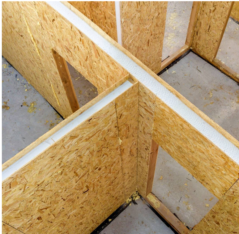
2.5.5. ábra SIP technológiával épült lakóépület
