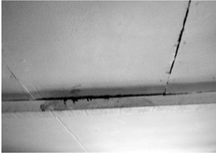
F.1.7. ábra Szerkezeti faanyagon keletkezett biotikus és abiotikus károk a vizsgált „Egervár” típusú hétvégi ház tetőfödém szerkezetén
