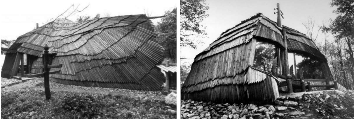
2.18. ábra „Granica” fedés alkalmazása (Beke et al., 2021, p. 60; Gerle and Götz, 2015a, pp. 84–85)
