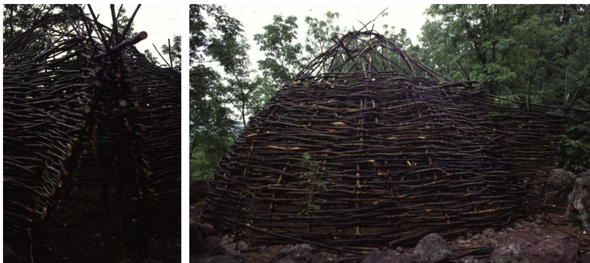
2.15. ábra Csúcstalálkozásában szabadon hagyott ágfonatos építmény (forrás: (Álmosdi et al., 2002, pp. 118–123)
