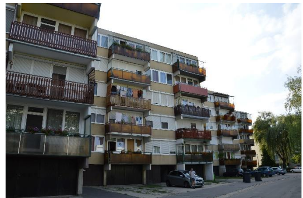
Sok épületnél a külső nyílászárók cseréje is megtörtént
