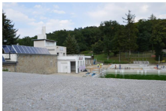
Felújított kiszolgáló létesítmény
