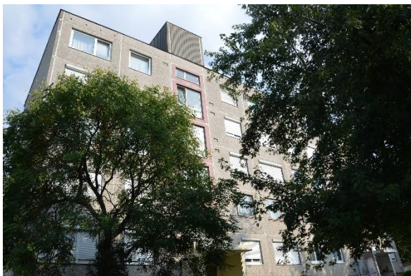
Néhány épületnél csak panelhézag-szigetelést végeztek
