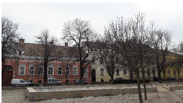
A teret szegélyező épületek is sorra megújultak
