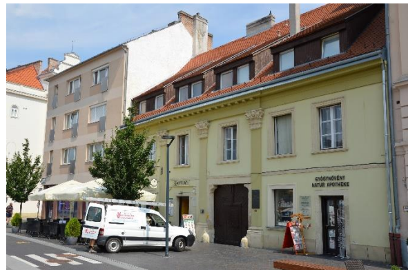
Felújított homlokzatú lakóépületek (Várkerület)
