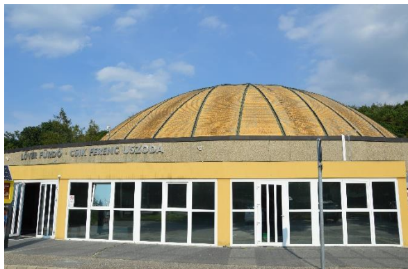
Az uszoda épülete
