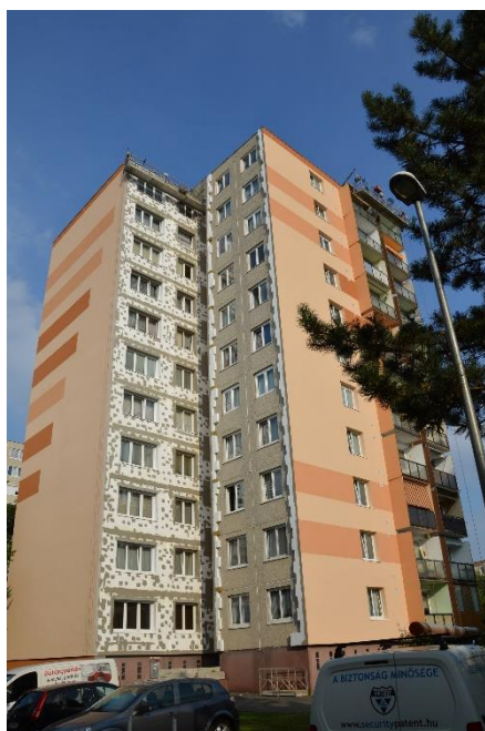
Folyamatban lévő homlokzatzelújítás
