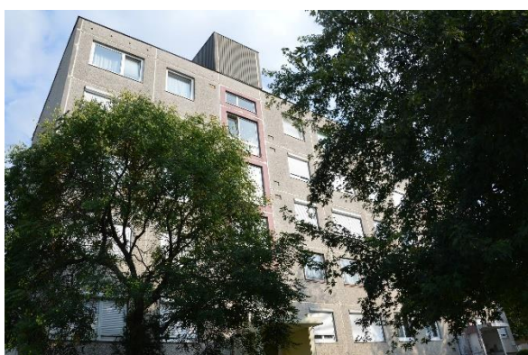
Néhány épületnél csak panelhézag-szigetelést végeztek
