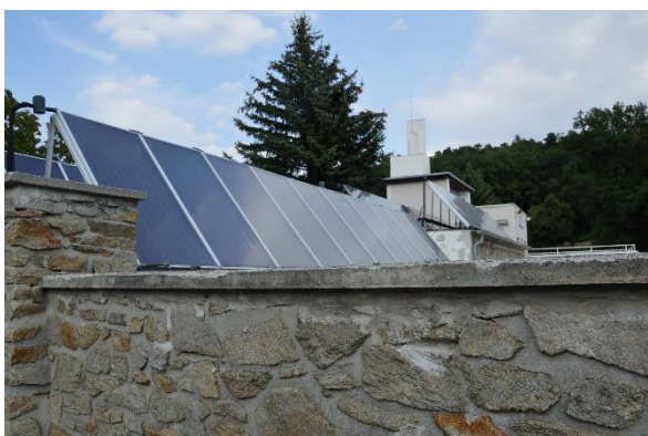
A fürdő energetikai célú korszerűsítése is megvalósul
