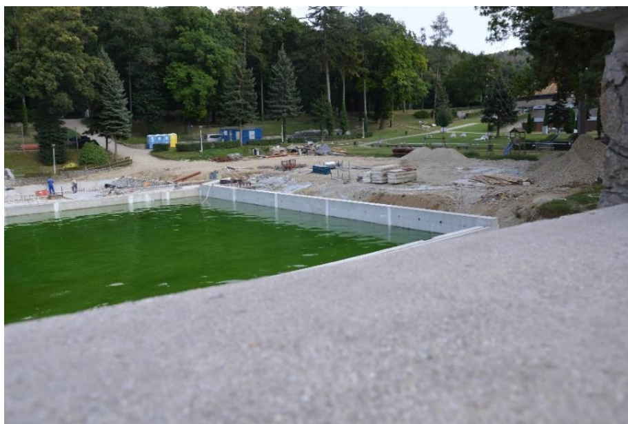
3. kép: A bővítés alatt álló Lővér Fürdő
