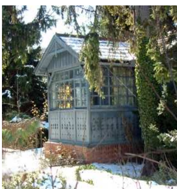
3.11. kép Felsőórházköz 2.. pallófalas toldalék
