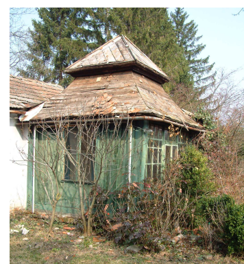
3.13. kép Felsőlőver pallófalas toldalék
