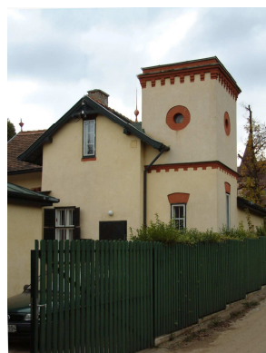
2.37. kép Felsőórház köz 11.
