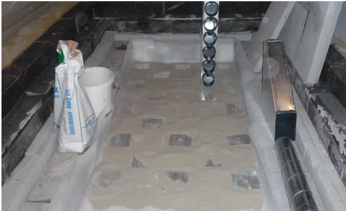
9. ábra. Hővezető rudak kiosztása. A képen egyebek mellett a hőszigetelő rendszer szerkezeti felépítése és a hőcserélő néhány eleme is látható (Kép forrása: NymE Innovációs Központ).
