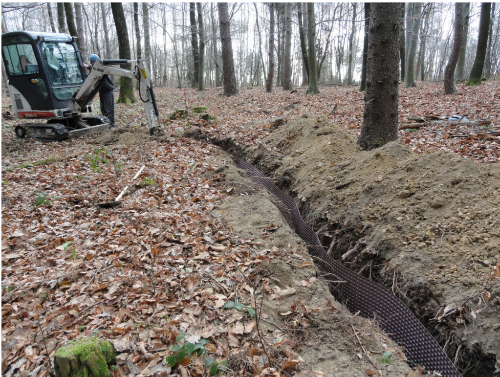
14. ábra. A szárított terület körülárkolása és a drénlemez elhelyezése.
