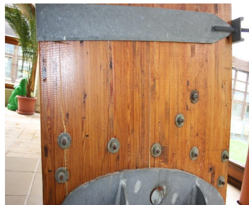
7. ábra A hajdúszoboszlói Városi Uszoda Tanmedence szétválása, pántolása
