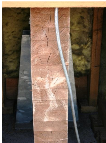
13. ábra A tapolcai rendezvénycsarnok reped tartójának bütüje
