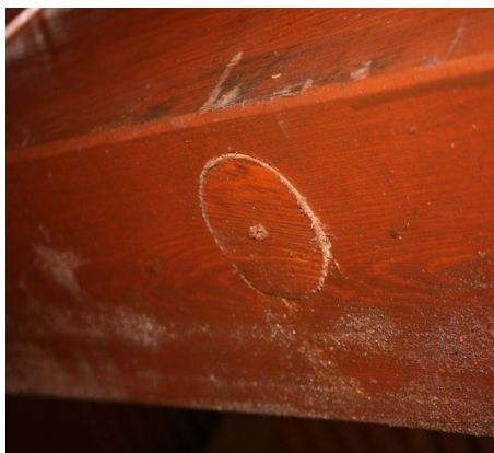
6. ábra Az egri sportuszoda utólagos összecsavarozása, dugózása
