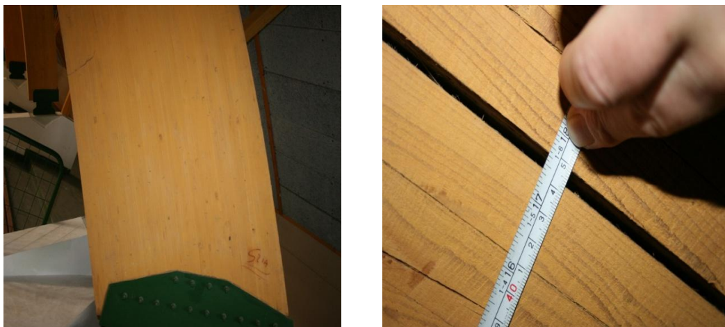
8. ábra A harkányi Tornacsarnok vékony lamellás ép és vastag lamellás repedt tartói.
