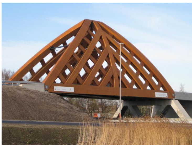
3. ábra Sneek, Hollandia, egy beépített acél pályalemez segítségével 60 tonna teherbírású a 32m hosszú és 12 m széles híd (Kovács 2011)
