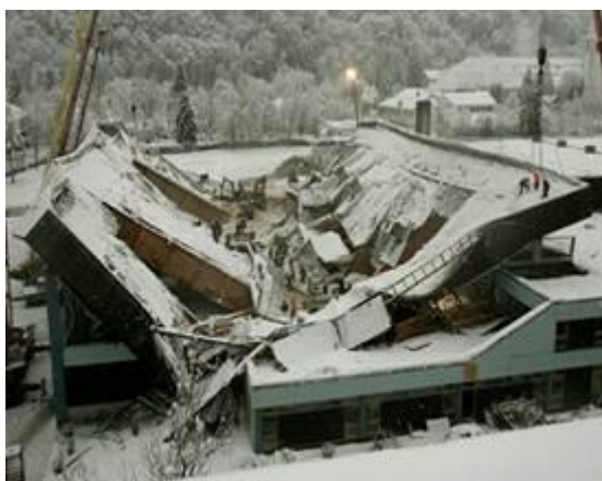
4. ábra A jégpálya beszakadt szerkezete.
