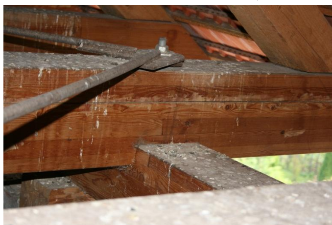
9. ábra A kisharsányi templom tetőszerkezetének repedése az erőbevezetésnél
