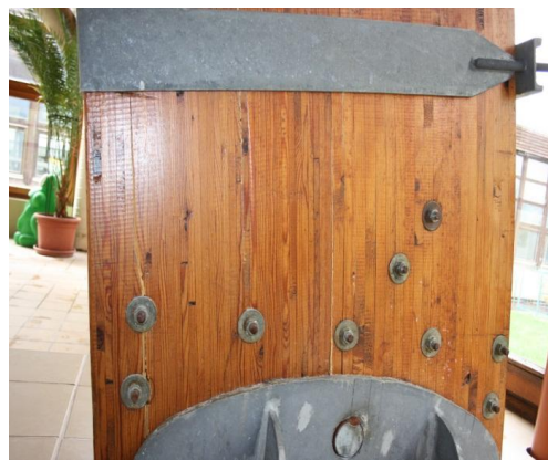
7. ábra A hajdúszoboszlói Városi Uszoda Tanmedence szétválása, pántolása
