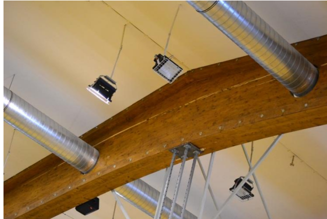
12. ábra Tapolca, városi rendezvénycsarnok: fogyasztás rész lerepedése
