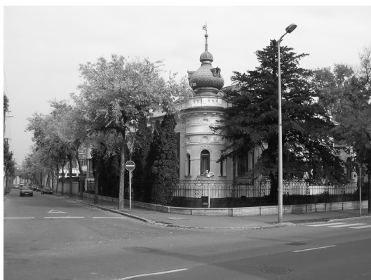
Villaszerű beépítés (Kossuth L. utca)
