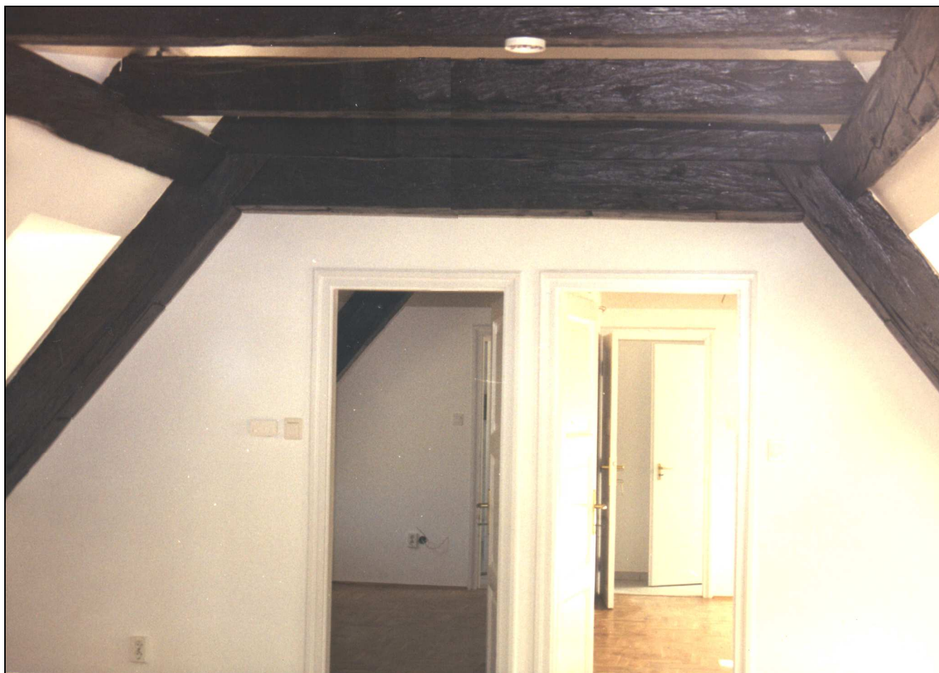
M14. ábra Az Esterházy palota. Tetőtérbeépítés a Dr. Kovács Pál utcai szárnyon Megmaradt, bemutatott szerkezeti elemek (a szerző felvétele) (ferde dúcok, mellszorító, fej- és torokgerendák)
