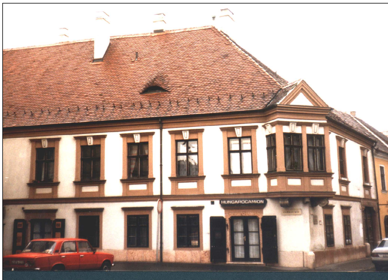
M9. ábra Győr. A Curia Nobilitaris felújított épülete, megmentett tetőszerkezete (a szerző felvétele)
