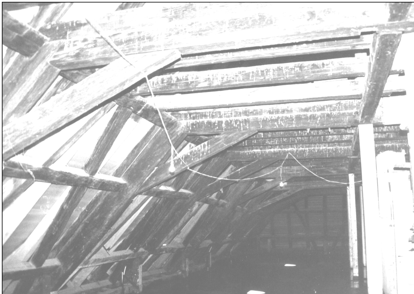
M15. ábra Az Esterházy palota. Tetőtéri szerkezetátalakítások a Király utcai szárnyon A hiányzó páros lengő függesztőfák helyén új gyámoszlopok (a szerző felvétele)
