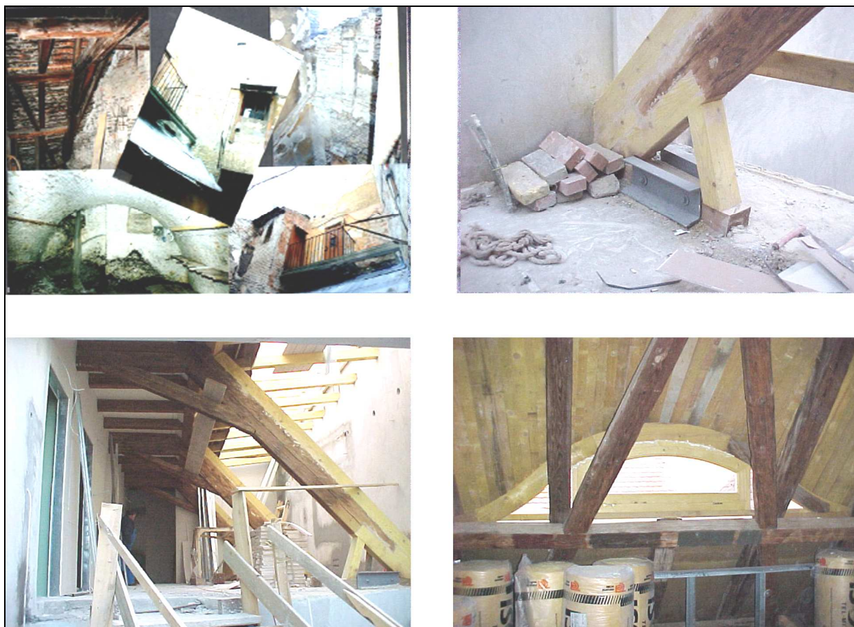
M19. ábra Győr. A Fejérvári ház felújítást megelőző állapota; A felújítás képei: kötőgerenda kiváltás, a burcsellás tetőváz főállásainak kitakarása, ferde rácsrudak közé illesztett ökörszem-ablak beépítése (Babarcsi László nyomán)
