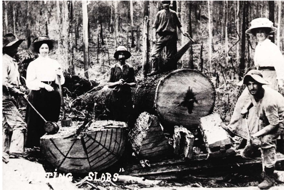
34. ábra A gőzhajtású fűrészmalom megjelenése előtt a farönkökből hasítással állítottak elő építési faanyagot
