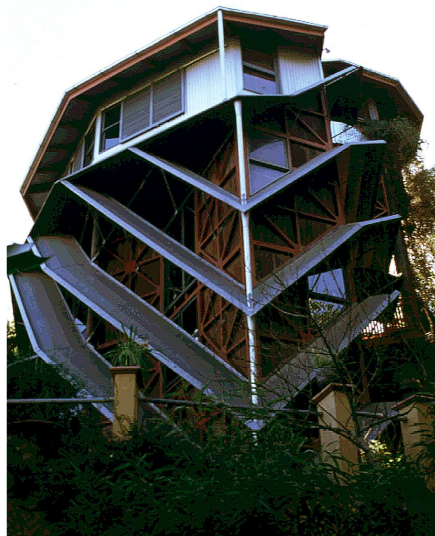
170. ábra A nap beesési szögére merőleges árnyékoló-esővédő ereszek
