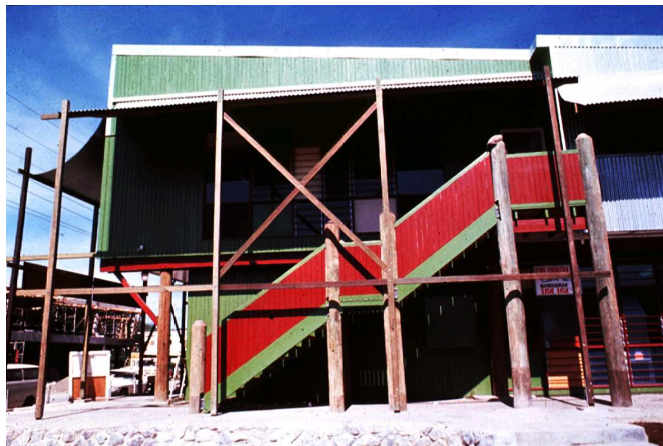
159. ábra A kivitelezett toalett szekció
