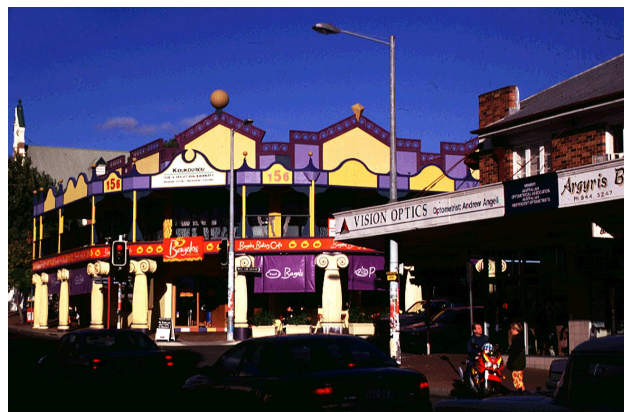
151. ábra Vulture street Boundary street sarképület átépítés, West End, Brisbane (1998)
