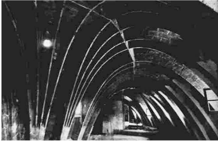
113. ábra Gaudí poétikus gazdaságosságának megnyilvánulása a Casa Milà tetőszerkezetében: paraboloid ívek alkalmazásával maximális stabilitás érhető el minimális anyagmennyiségből
