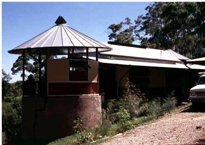
143. ábra Hall, A silótetőt hasznosító Celladon ház, Sunshine coast (1997)
