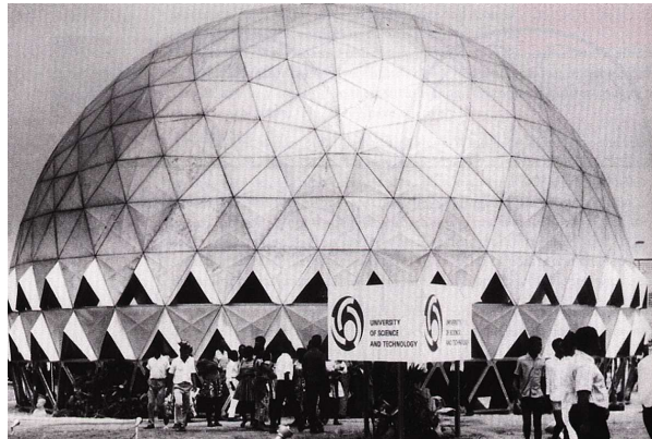
138. ábra Fuller szigetetlen alumínium kupolája Ghánában, melyet a gondos tervezéssel előregyártott alkatrészekből rövid idő alatt helyi szakképzetlen munkaerővel állítottak össze. Az alsó részen elhelyezett csuklyás nyílásokkal a természetes szellőzés következtében a belső hőmérséklet 20 fok körüli.
