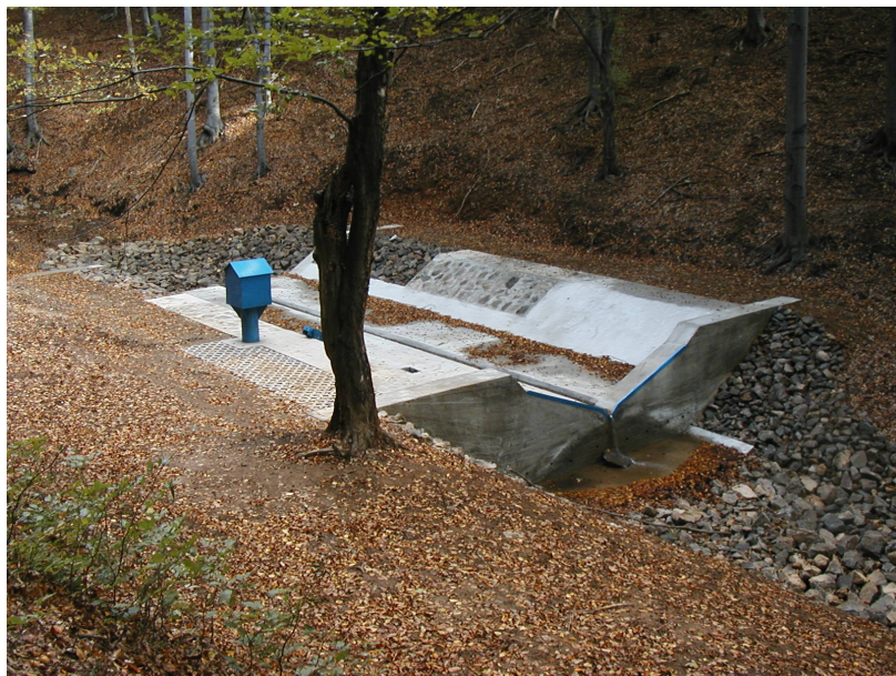
1.8. ábra. A Nyírjes egyik részvízgyűjtőjén létesített vízhozammérő műtárgy
