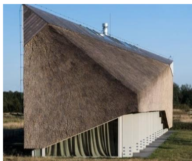
33. ábra. Nádfedés (forrás: A)
