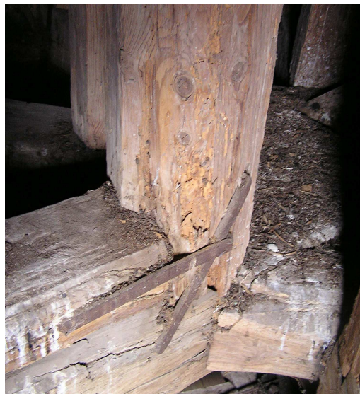
a keretváz-oszlop alja kb. 5-6 cm mélyen rovarrágott 348
