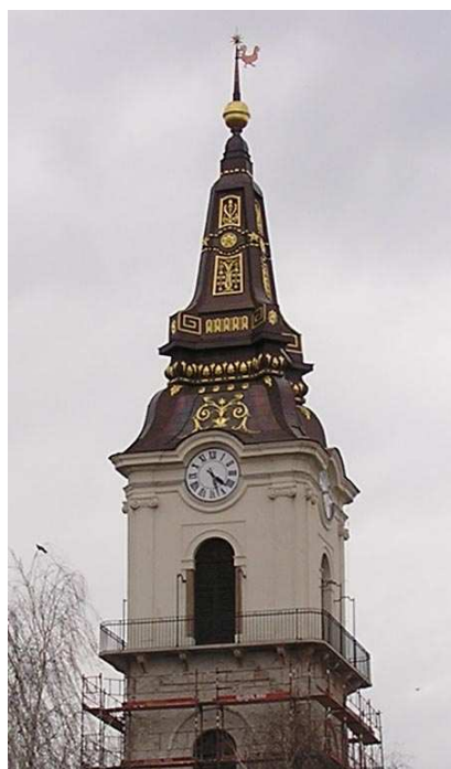
a felújított torony 365
