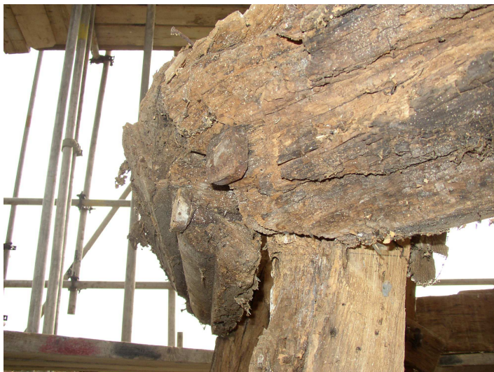
a szelemen-koszorú szinte teljesen elkorhadt 366
