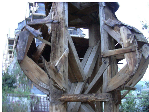
a sisak teljesen tönkrement fedélszerkezete 395 ( András-keresztekkel merevített többszintes toronysisak szerkezet )
