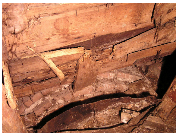
a deszkázat teljesen elkorhadt és rovarrágott is 353
