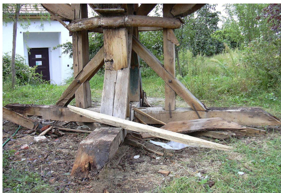
a sisak teljesen tönkrement fedélszerkezete 395 ( András-keresztekkel merevített többszintes toronysisak szerkezet )
