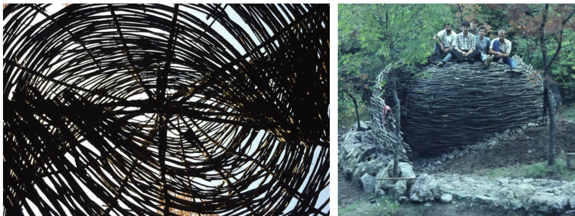
2.14. ábra A vesszőfonat teherátadása működőképes (táborozók súlyátadása a szerkezetnek), (forrás: (Álmosdi et al., 2002, pp. 89–102; Czégány et al., 2022b)
