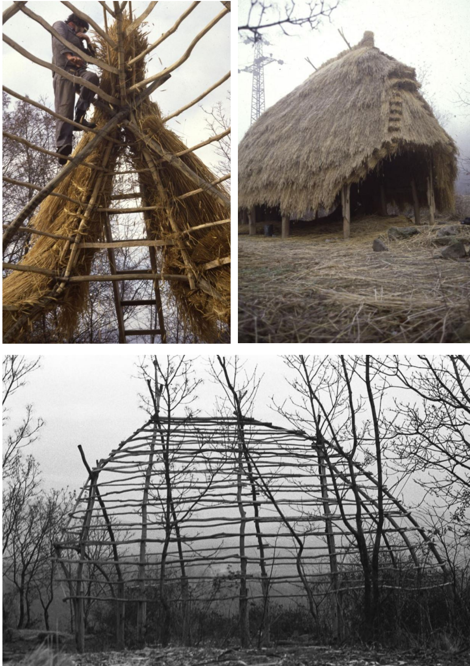
2.13. ábra A Csűr tartószerkezetének váza és héjazatának készítése (forrás: (Álmosdi et al., 2002, pp. 79–83))
