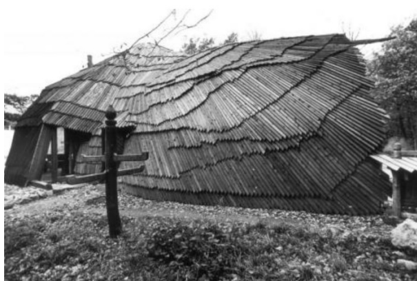
2.18. ábra „Granica” fedés alkalmazása (Beke et al., 2021, p. 60; Gerle and Götz, 2015a, pp. 84–85)
