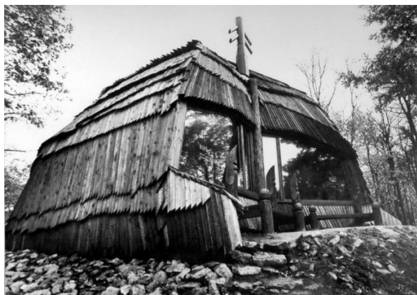
2.18. ábra „Granica” fedés alkalmazása (Beke et al., 2021, p. 60; Gerle and Götz, 2015a, pp. 84–85)
