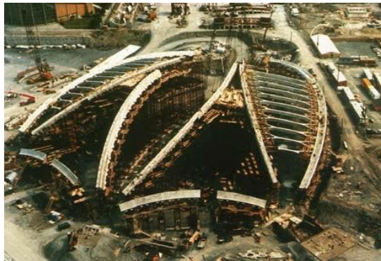
30. kép: Montreal Velodrome építése (1973-1976) [Xercavins et al. 2011]
