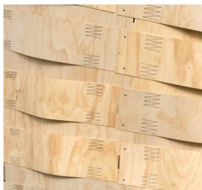
52. kép: fafurnérból összevarrt fal [Garufi et al. 2019]
