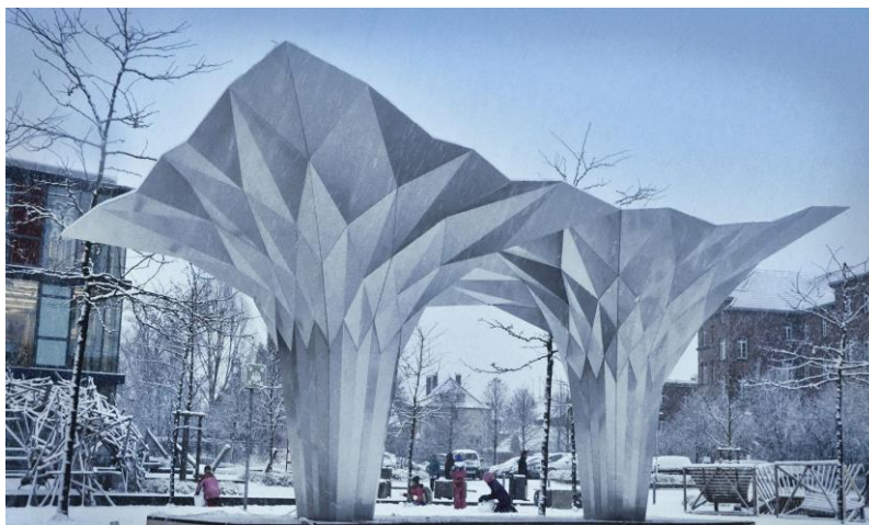
35. kép: Fold Finding Origami Pavilion alumínium szendvicslemezekből áll [Friedman 2016]
