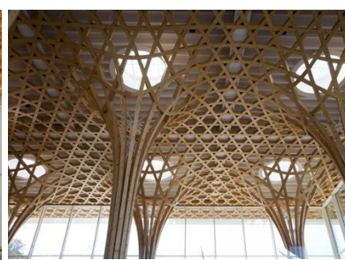
40. kép: Heasly Nine Bridges [SBA 2010]
