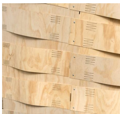
52. kép: fafurnérból összevarrt fal [Garufi et al. 2019]
