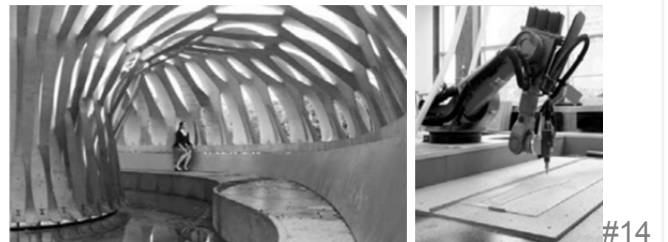
#14: A pavilon külső és belső képe, az elemek szabása CNC technológiával. [FleM2011]
