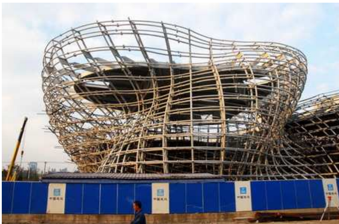
10.2.2 ábra: a spanyol pavilon szerkezeti váza
