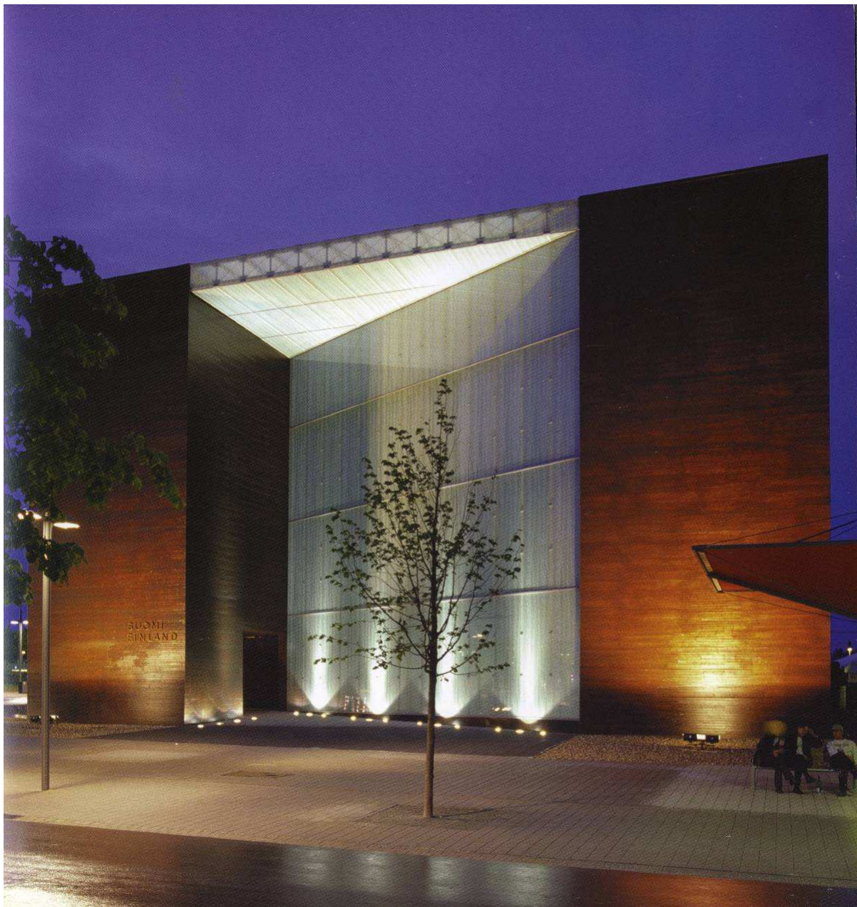
9.13.3 ábra: a finn pavilon véghomlokzata
