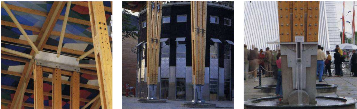
8.6.2 ábra: az előtető szerkezeti részletei
