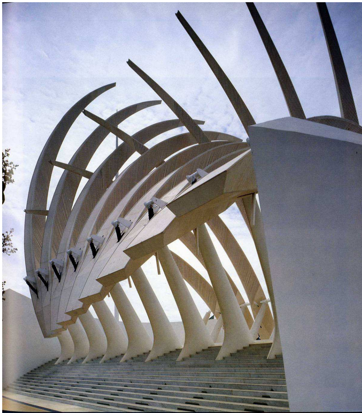
8.2.1 ábra: a kuvaiti pavilon mozgatható „bordái”
