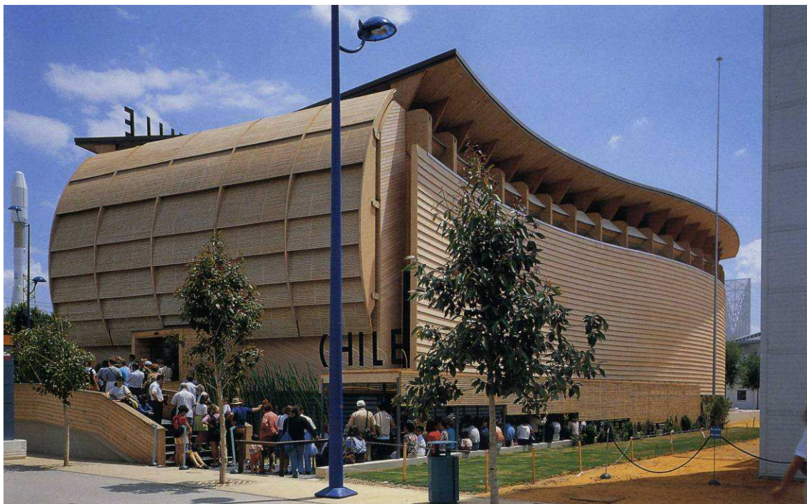
8.4.1 ábra: a chilei pavilon külső megjelenése
