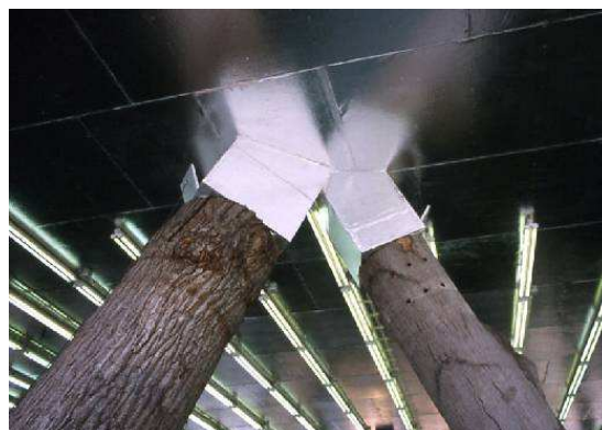
9.3.5 ábra: a fatörzsek tartószerkezeti részletei
