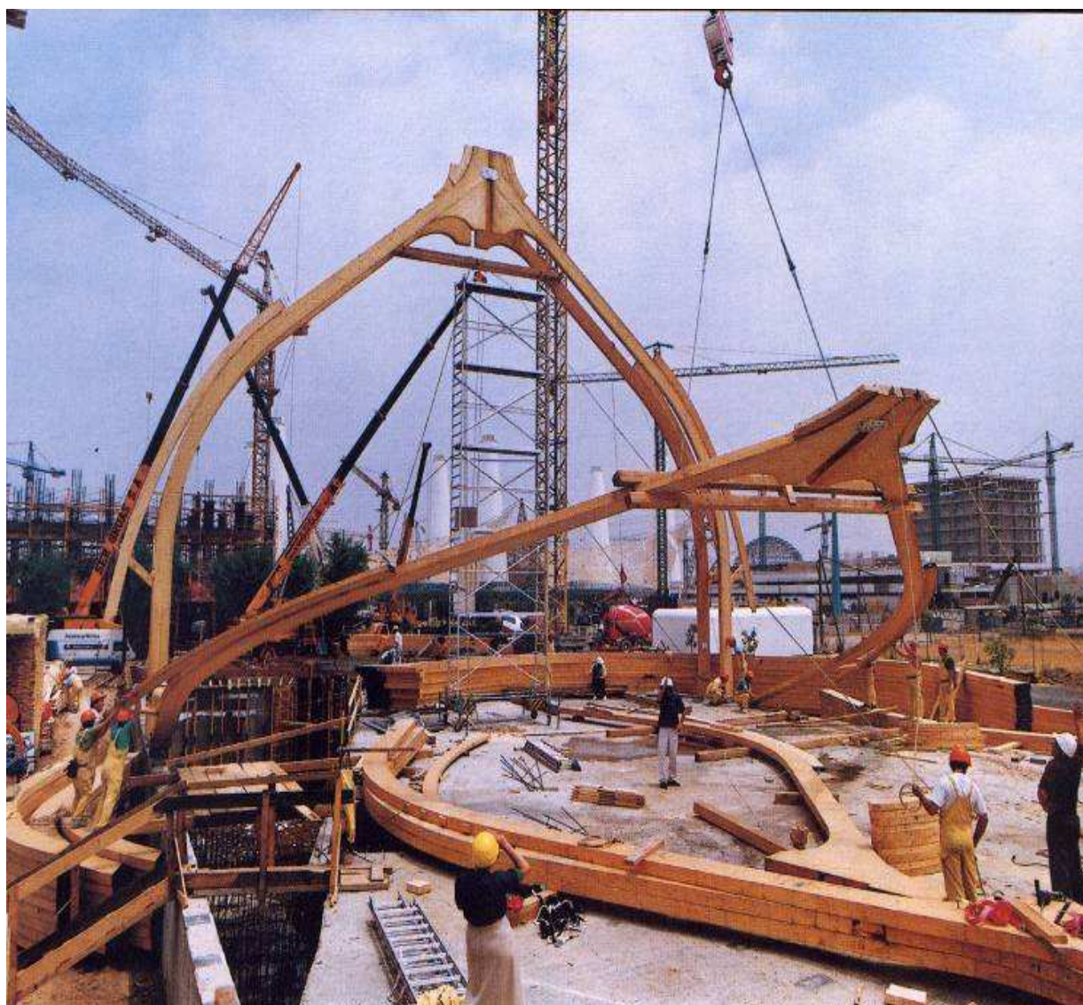
8.14.8 ábra: az íves ragasztott fatartók felállítása
