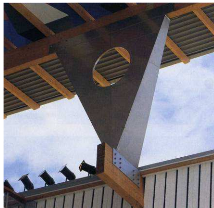
8.6.3 ábra: az előtető szerkezeti részlete – csatlakozó elem
