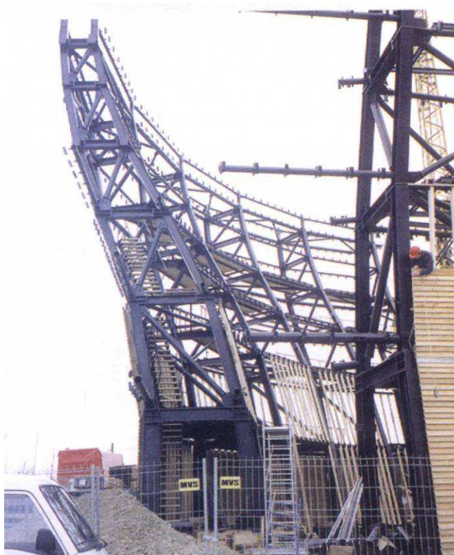
9.8.4 ábra: az acél vázszerkezet építés közben
