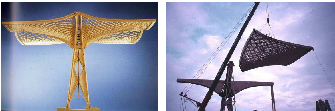
9.6.2 ábra: a tető alap modulja és egy modul beemelése
