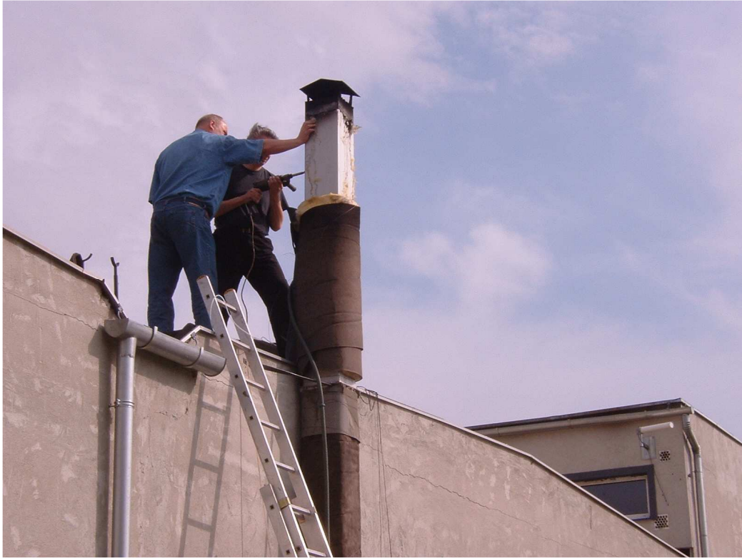
A MINTAVÉTELI HELY KIALAKÍTÁSA A KÉMÉNYEN
