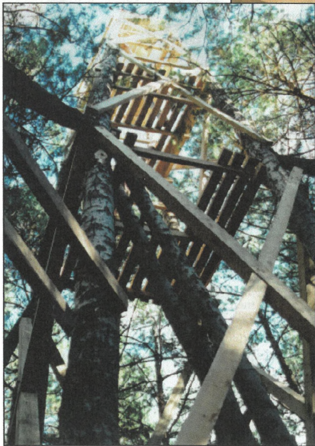
4. KÉP: AZ ÁLLOMÁNY FELETTI MŰSZEREK ELHELYEZÉSÉRE SZOLGÁLÓ TORONY
